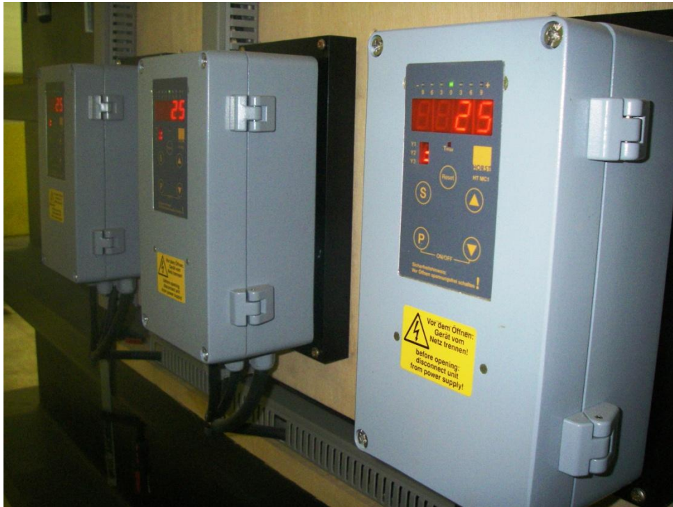
Abbildung 28: Reglereinheiten für Heizplatten
